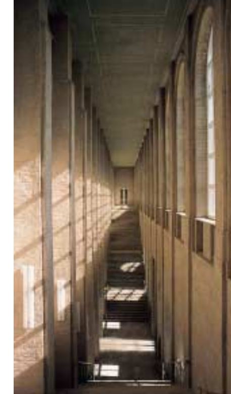
Treppe Alte Pinakothek München, Architekt: Leo von Klenze, Wiederaufbau Hans Döllgast Fotos (7): Autor
